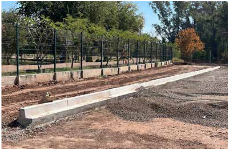
Los trabajos de ampliación del estacionamiento del Laguna Gym presentan más de un 80 por ciento de avance.
