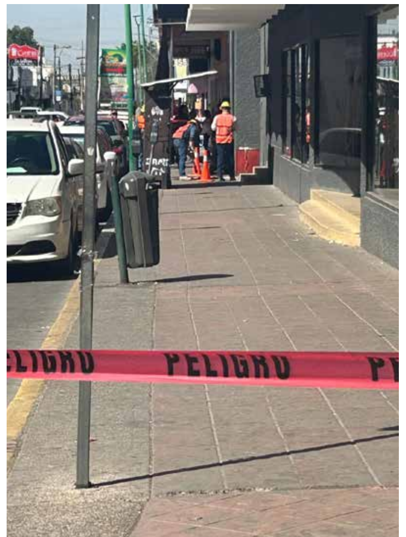
Comerciantes piden reforzar revisiones tras falla eléctrica.
