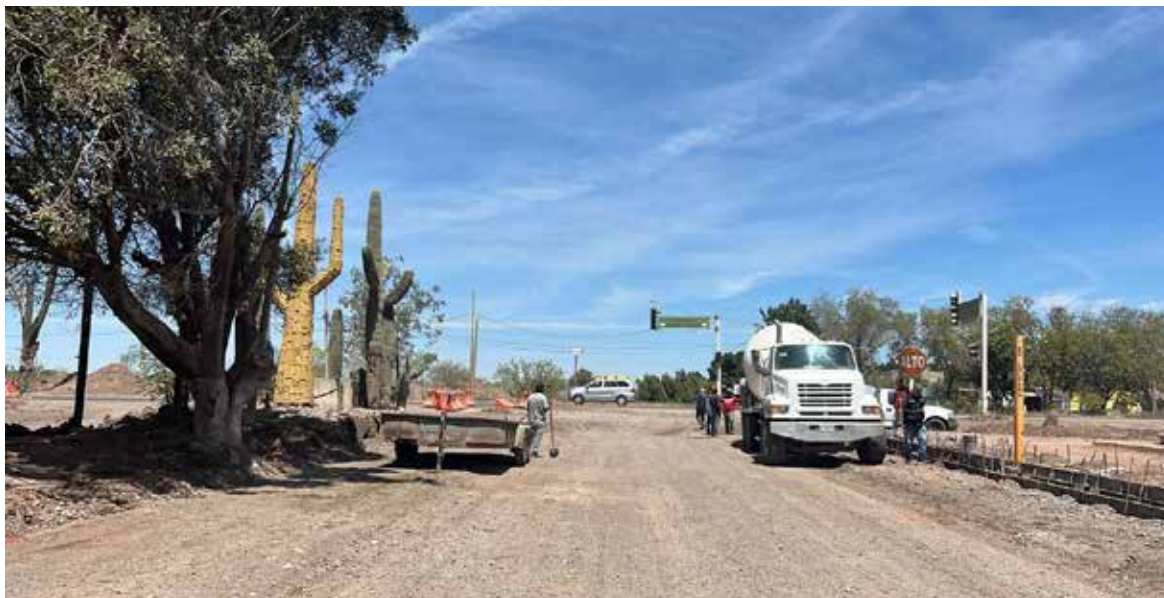
Al menos un 75 por ciento de avance presenta la obra de rehabilitación del bulevar Circunvalación en el Parque Industrial de Ciudad Obregón.
