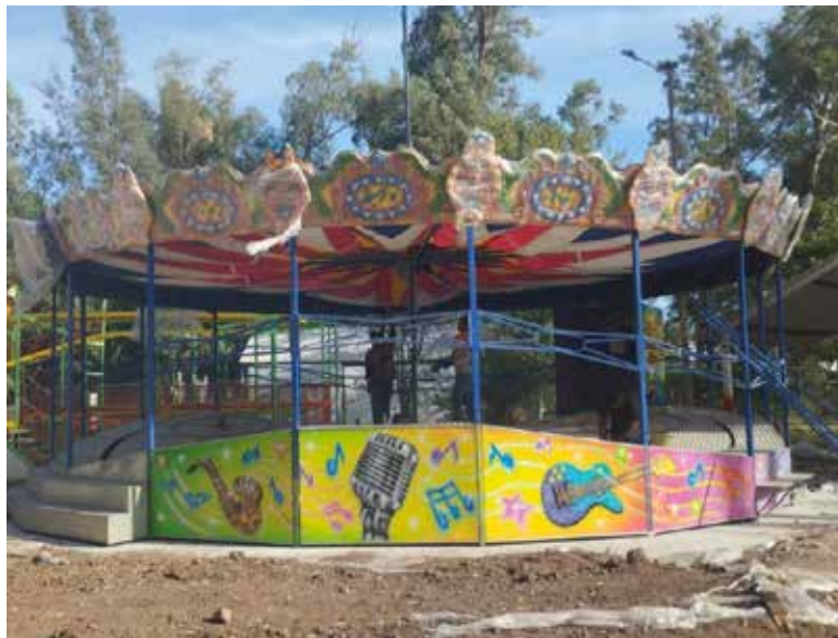
Aunque los contratistas estiman que la obra del Parque Infantil quedará concluida en mayo, el alcalde de Cajeme señaló que se buscará terminar al menos lo más básico de este espacio para el Día del Niño.
