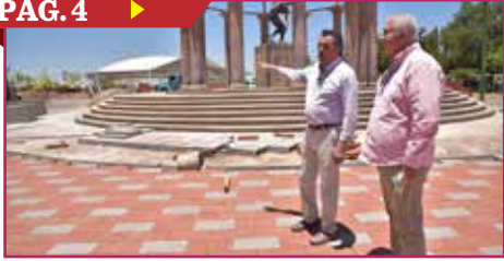
SUPERVISA ALCALDE AVANCE DE OBRAS
