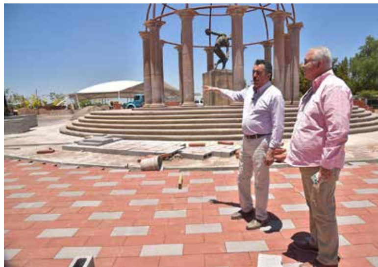
El presidente municipal de Cajeme, Javier Lamarque, supervisó importantes obras de infraestructura en distintos puntos de la ciudad, acciones que forman parte de la transformación que vive el municipio.
