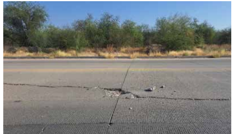
La calle Juan R. Bours, construida con concreto hidráulico sigue presentando un notable deterioro lo que significa un riesgo para quienes transitan por la zona.
