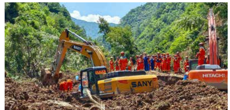
Una evaluación preliminar indicó que el deslizamiento fue causado por una combinación del terreno escarpado, la erosión y la estructura geológica de la zona.
