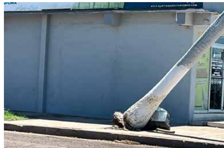
Daños menores dejó la lluvia acompañada de fuertes vientos registrada la noche del martes en Cajeme, donde se atendieron entre ocho y nueve reportes.
