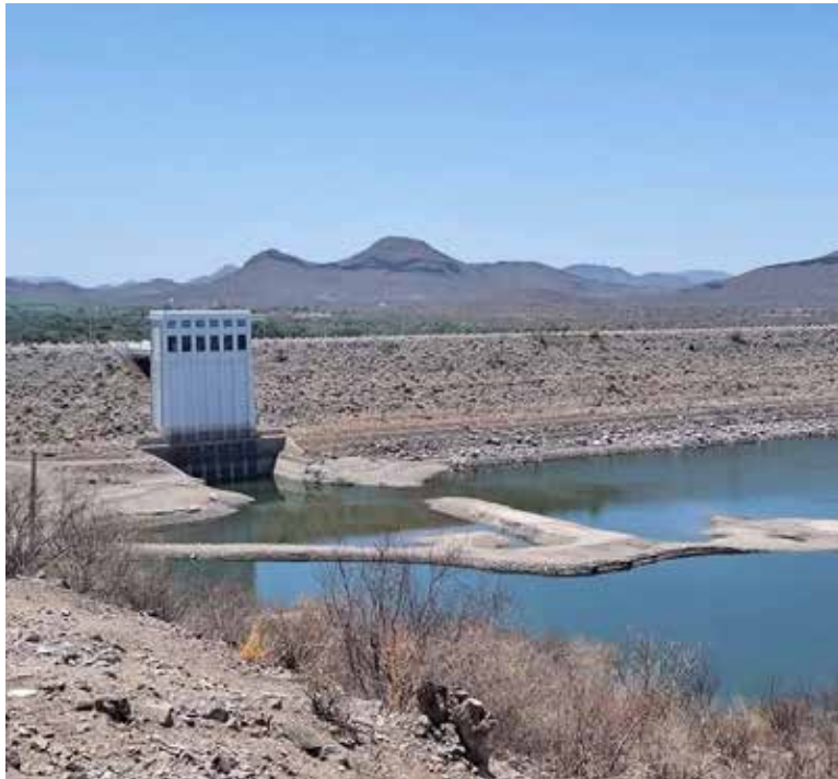
Distrito de Riego No. 041.
