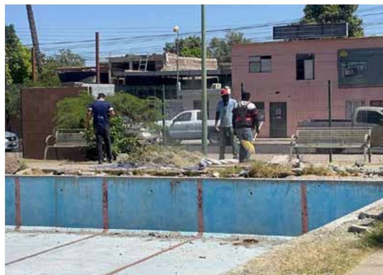
El director del Instituto del Deporte Municipal de Cajeme, Rodrigo Minjares, aclaró que la obra continúa, aunque los avances no sean visibles desde el exterior.
