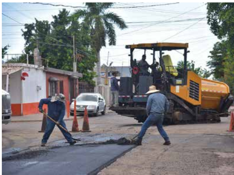
Suman 22 vialidades rehabilitadas en Cajeme.
