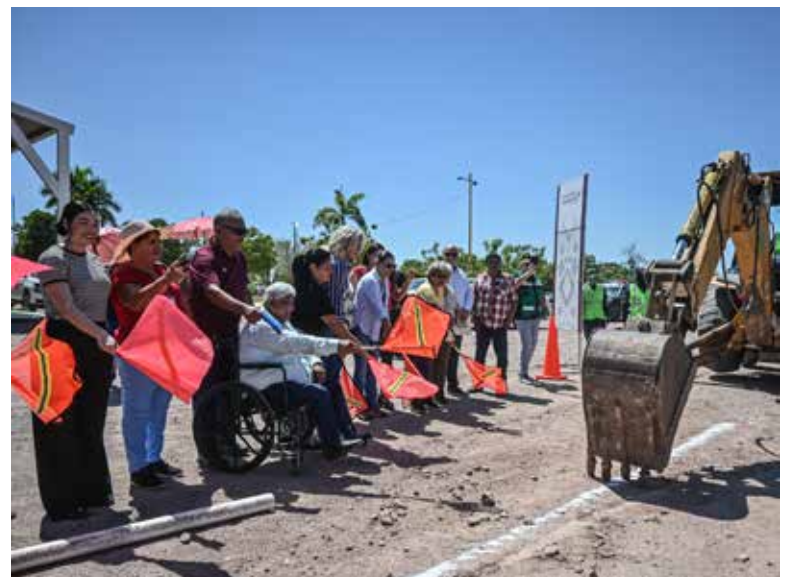
Se pusieron en marcha los trabajos para la rehabilitación de la red de agua potable en dos cuadrantes de la Comisaría de Marte R. Gómez-Tobarito
