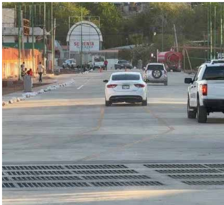
Obra hidráulica de Nogales requiere nuevas etapas: SIDUR.
