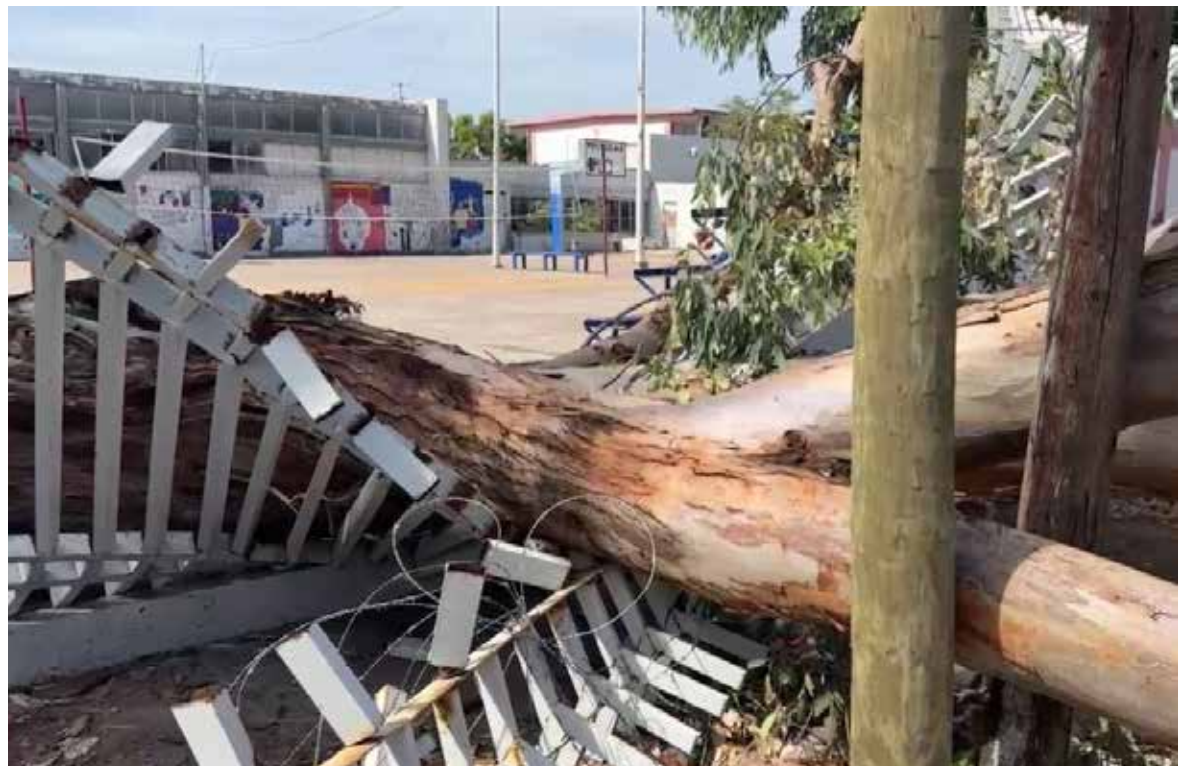
En la Escuela Secundaria Técnica #2 se registró la caída de un árbol de eucalipto, lo que dañó la barda perimetral; pese a esto el regreso a clases se dio con normalidad.
