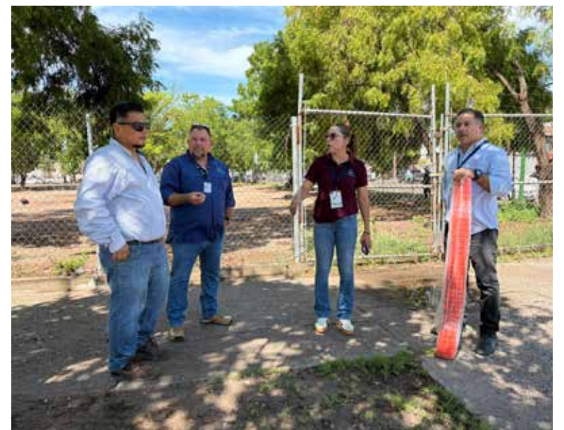
Personal directivo y operativo del Oomapas realizó un recorrido de inspección para evaluar los daños y verificar el funcionamiento de la infraestructura de drenaje.
