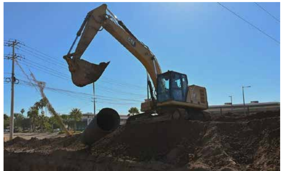
Los trabajos para la construcción del colector de la avenida 300 podrían concluir para finales de este 2026.
