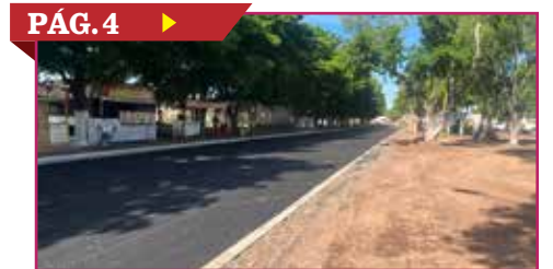
EN FASE FINAL OBRA EN LA 300
