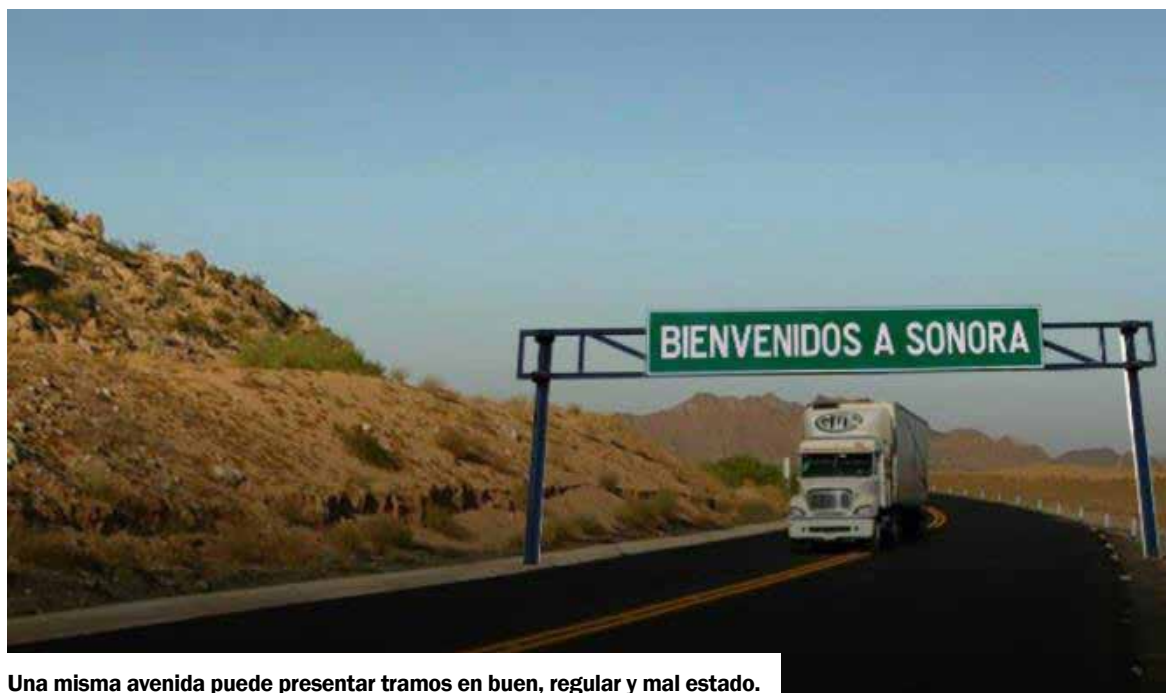
Una misma avenida puede presentar tramos en buen, regular y mal estado.
