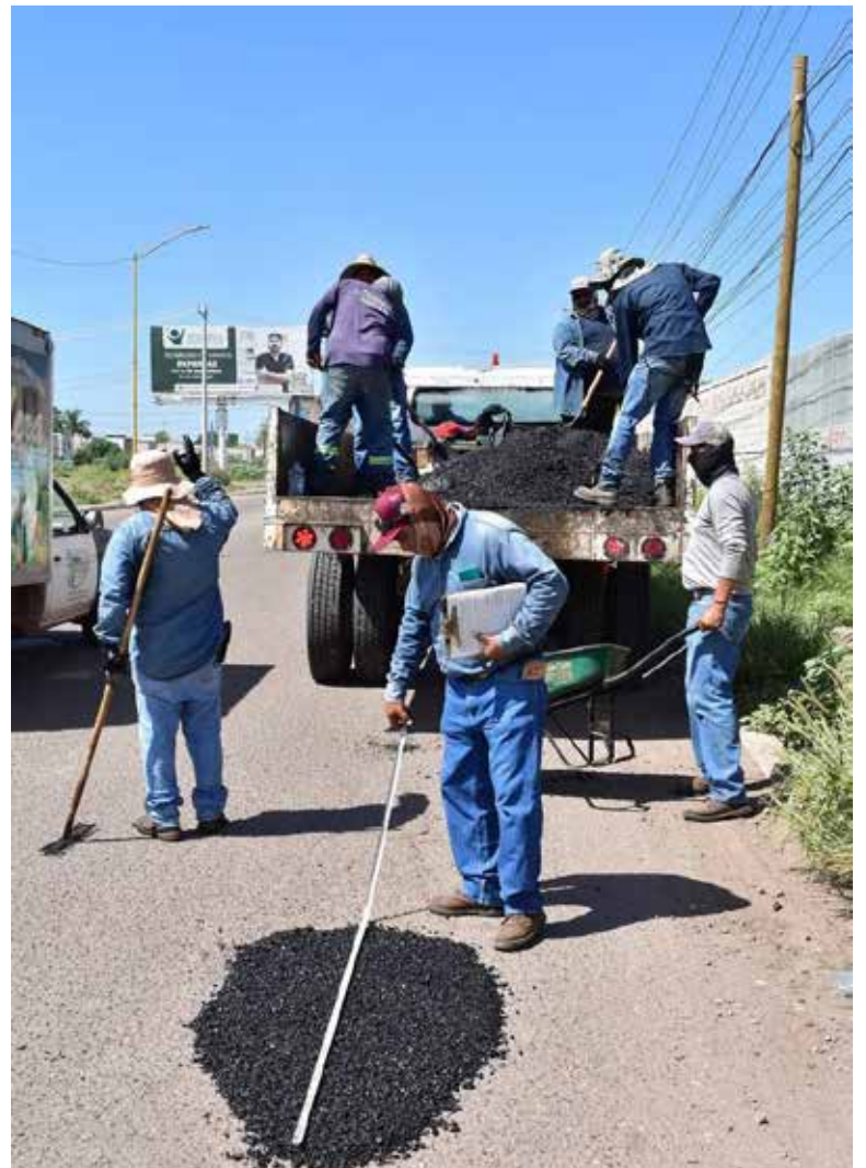
Este apoyo especial tiene el objetivo de intensificar los trabajos de rehabilitación de las calles que han resultado dañadas a consecuencia de las lluvias registradas en el municipio.
