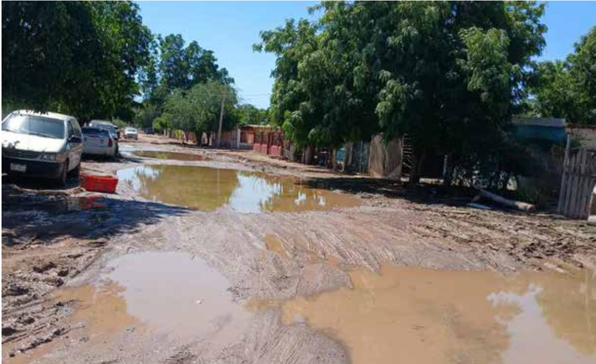
El estancamiento de agua de las pasadas lluvias y una fuga de drenaje en las calles Veteranos de la Revolución y Unión de Ejidos, de la colonia Zona Urbana, han generado preocupación entre habitantes del sector.
