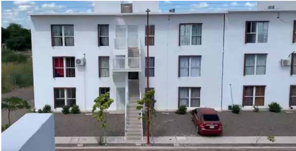
En un plazo máximo de dos meses, las Viviendas del Bienestar en Ciudad Obregón que ya fueron entregadas contarán con medidores individuales de electricidad.
