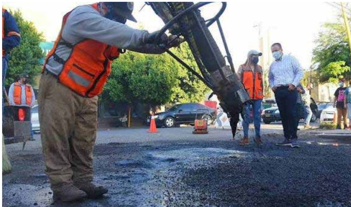
La intervención se sumará a los trabajos permanentes de bacheo.
