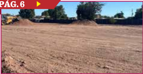
PREPARAN TERRENO PARA CONSTRUIR PLAZA
